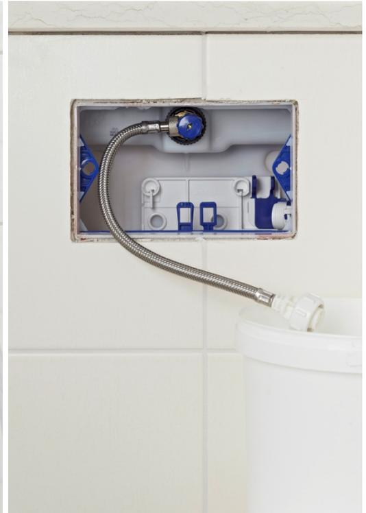
Fig. D-14 : Réservoir de chasse – lavage sans démontage de la vanne-équerre selon le fabricant
