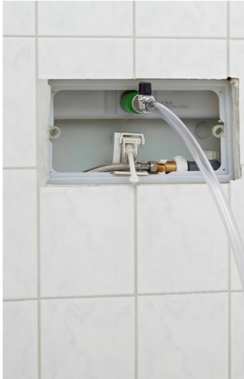
Fig. 13 : Réservoir de chasse d'eau (vanne-équerre démontée) avec bouchon de construction et robinetterie de lavage
