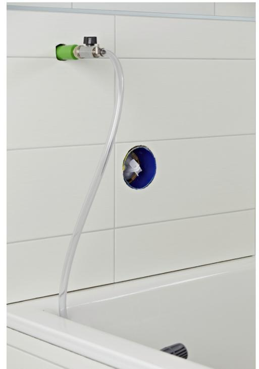
Fig. D-12 : Point de prélèvement sur la robinetterie de la baignoire avec bouchon de construction et robinetterie de lavage, ainsi qu'un dispositif de purge du fabricant de la robinetterie dans la robinetterie encastrée pour le lavage séparé des conduites d'eau froide/chaude.
